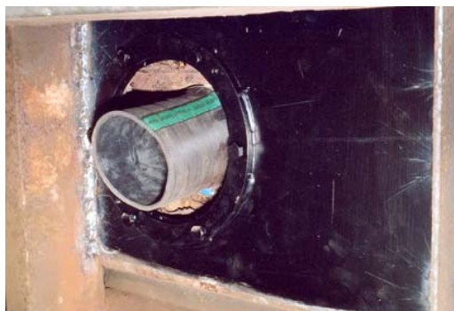
Zelfde pijp, nu met montageplaat. (Foto: Ruud van Schaik)
